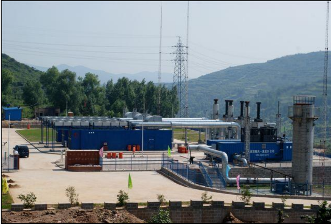
Figure 9.6 Phase 1 de la centrale de cogénération alimentée par du méthane de houille à la mine D
