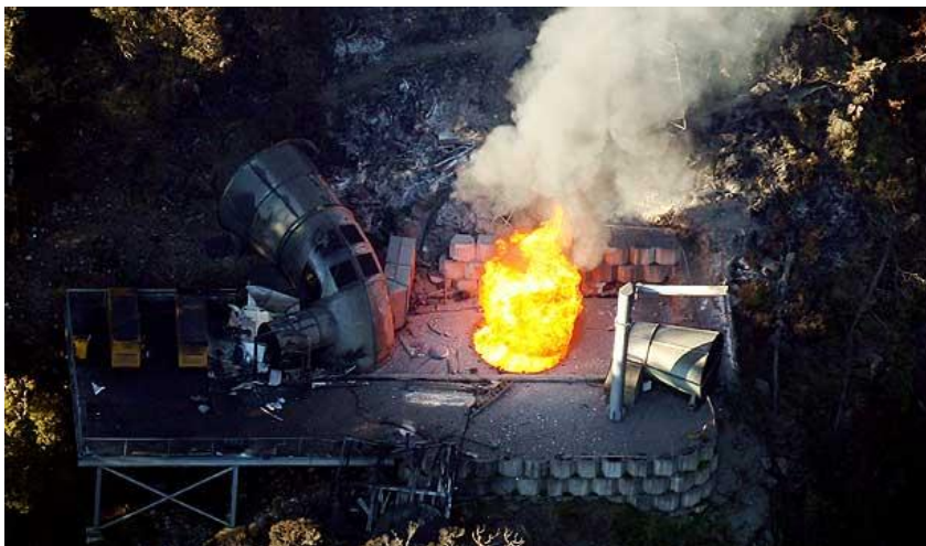
Figure 9.12 Incendie au niveau du puits de retour d'air après la troisième explosion
