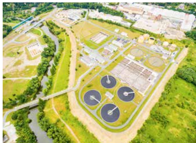
Городские очистные сооружения на 165 000 жителей, вид с воздуха; г. Пльзень, Чешская Республика
