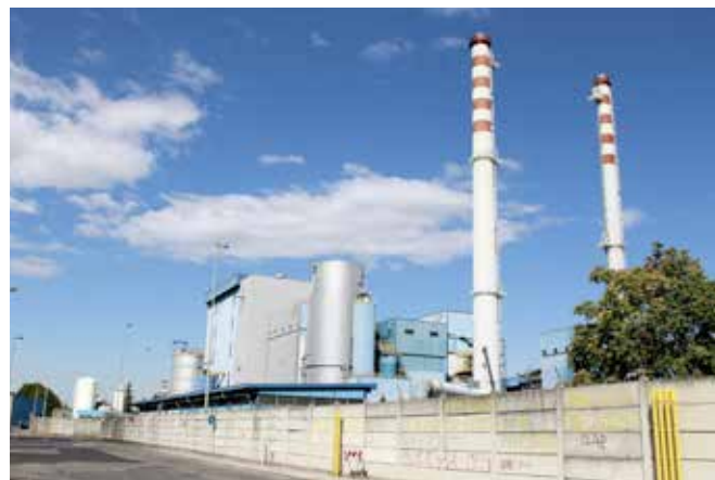
Завод по производству энергии из отходов в Ломбардии, Италия
