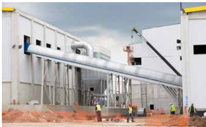
Строительство объекта по управлению отходами в Болгарии Фото: Shutterstock/Cylonphoto
