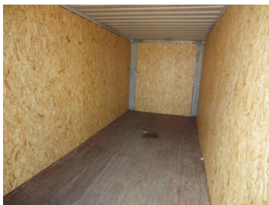
Figure 7.53 - Revêtement d'un conteneur de 40 pieds (12 m) à l'aide de panneaux en bois aggloméré
