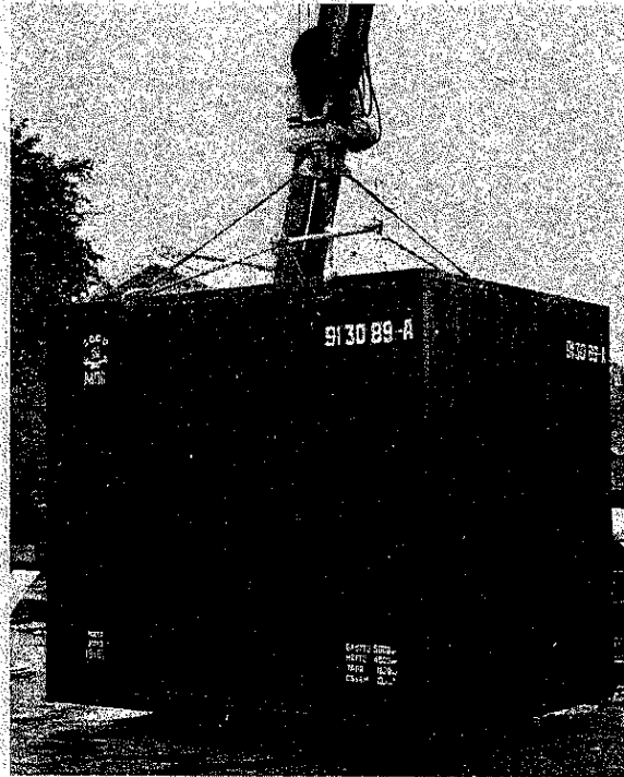
Fig. 11 - URSS: manutention à la grue d'un grand container de 5 t. de charge utile
